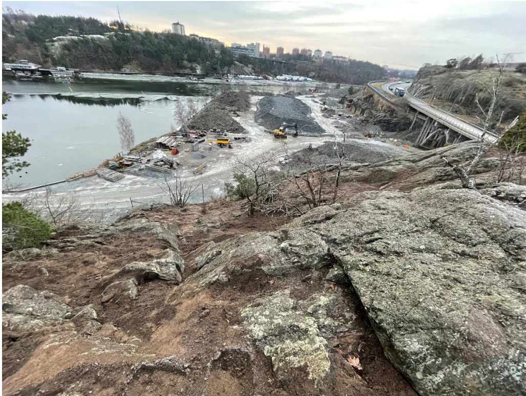
Figur 6-6 Bilder från tidigare åtgärd där delar av yttlig jord togs bort samt att återfyllning och täckning utfördes på delar av området. Här sparas träd och vissa värdefulla miljöer-
